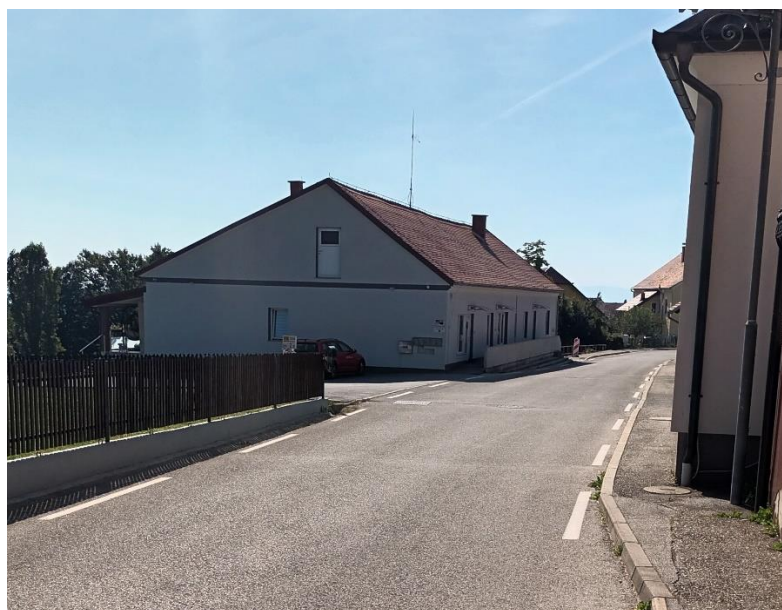
Ozki pločnik nasproti hišne številke Destrnik 13. Ni prehoda za pešce pred večstanovanjsko zgradbo.
